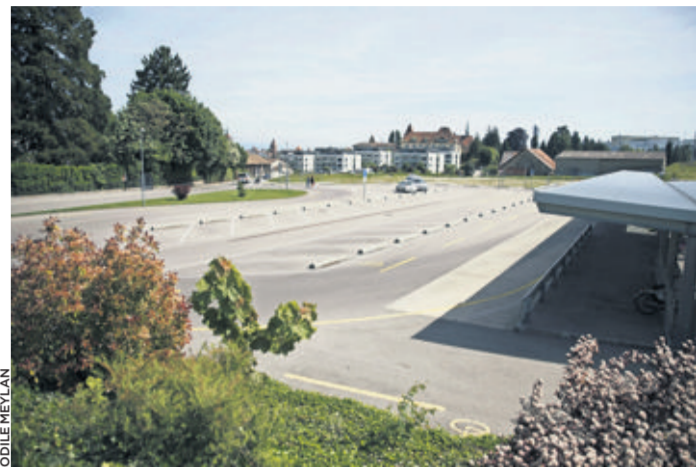
La gare routière des TPF (à dr.) sera déplacée pour laisser place à des commerces, voire un centre commercial.
